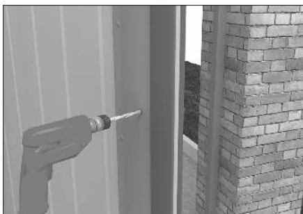
Просверлите 2 отверстия Ø 12 в створке.
