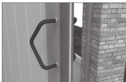
Разметьте отверстия для установки ручки.
