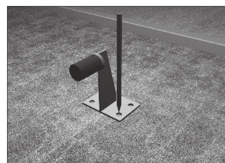
Разметьте место для бокового упора.
