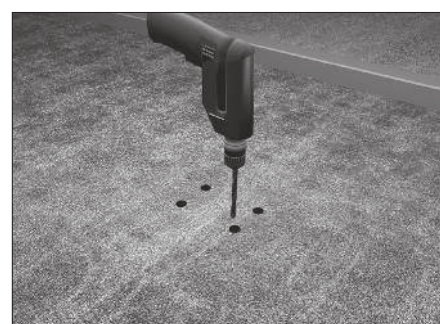
Просверлите 4 отверстия Ø13 в дорожном покрытии.
